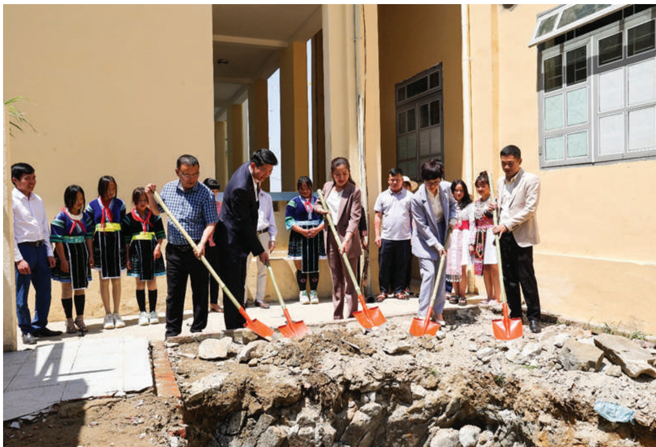
Lễ khởi công xây dựng khu vệ sinh cho học sinh Trường Phổ thông dân tộc Bán trú THCS xã Đào Sơn
